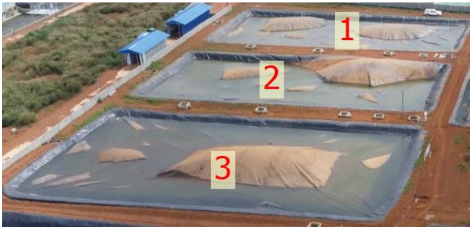
Hình 3.8: Hình ảnh hầm Biogas
