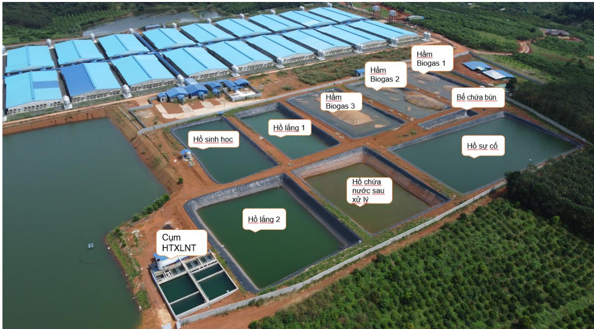
Hình 3.7: Hình ảnh hệ thống xử lý nước thải tập trung của trang trại Thuyết minh quy trình hệ thống thu gom và xử lý nước thải tập trung :
