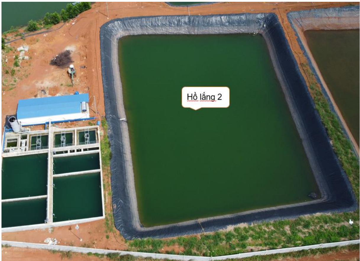
Hình 3.10: Hình ảnh bể lắng 2
